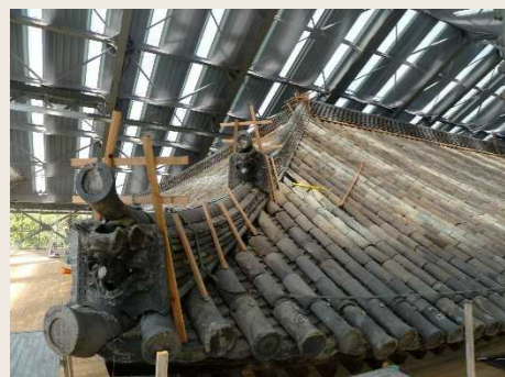
①工事前屋根の状況(H24.4)
