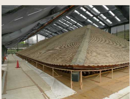
③瓦・葺土・土留棧撤去後の状況(H24.6)
