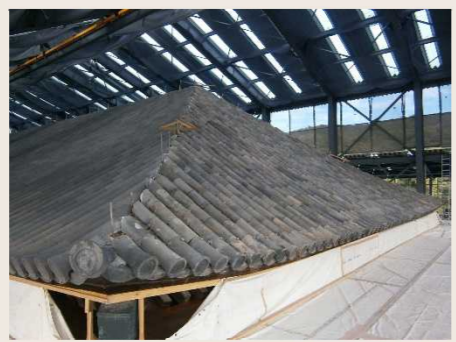
⑧丸瓦が葺かれた状況(H25.10)
