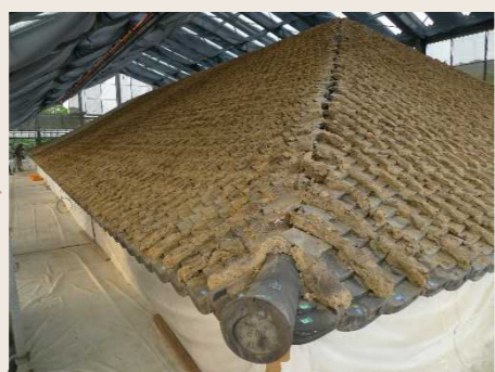
②丸瓦撤去後の状況(H24.5)
