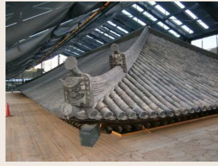
⑨屋根瓦葺きが完了した状況(H25.11)
