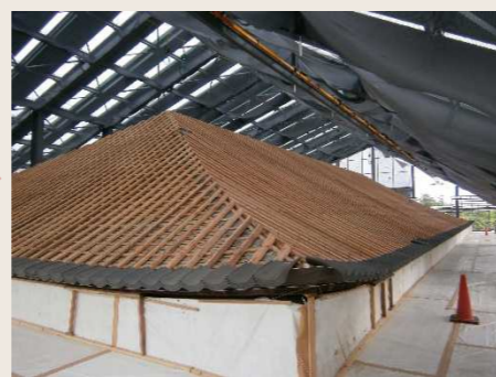
⑥軒平瓦の取付け後(H25.7)
